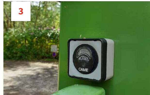
CELLULE PORTILLON POUR LES PIETONS COTE INTERIEUR
